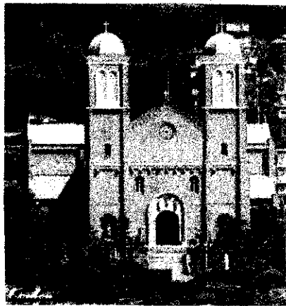
一九五九(昭和34)年、廃墟跡に復興された現在の浦上天堂
